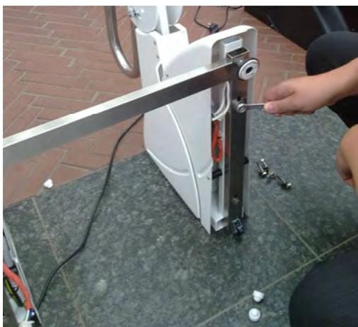
3. Nach Anschluss der Verbindungskabel das Verbindungselement mittels der mitgelieferten Schrauben an den Füßen festschrauben.
