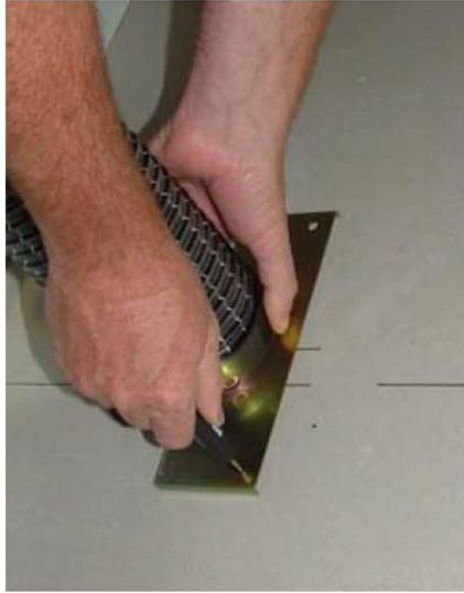
8. Führen Sie den Ablassschlauch durch den unteren Teil der Maschine, und legen Sie die Maschine in ihre Position. Mit den Wandbefestigungsschrauben anpassen. Der gewünschte Abstand kann durch Einstellen der 1 Mutter und 1 Unterlegscheibe an jedem Bolzen erreicht werden. Sobald dies geschehen ist, werden die restlichen 1 Scheibe und 1 Nuss auf sie gelegt. Befestigen Sie die Maschine, indem Sie die Muttern festziehen.
