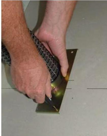
9. Führen Sie den Ablaufschlauch durch den unteren Teil der Maschine (fädeln Sie ihn ein) und bringen Sie die Maschine in ihre Position. Stellen Sie es mit den Wandbefestigungsschrauben ein. Der gewünschte Abstand kann durch Einstellen von einer Mutter und einer Unterlegscheibe an jeder Schraube erreicht werden. Sobald dies erledigt ist, werden die verbleibenden eine Unterlegscheibe und eine Mutter auf sie gelegt. Befestigen Sie die Maschine, indem Sie die Muttern festziehen.
